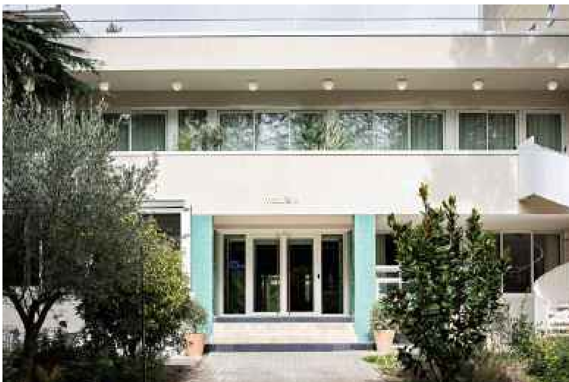
Le bâtiment aujourd'hui
